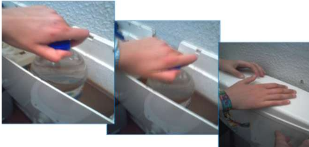
Figura 2 - Instalação de garrafas de água em autoclismos
