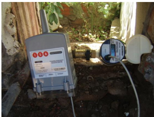
Figura 4 – Exemplo de uma instalação do equipamento de telecontagem
